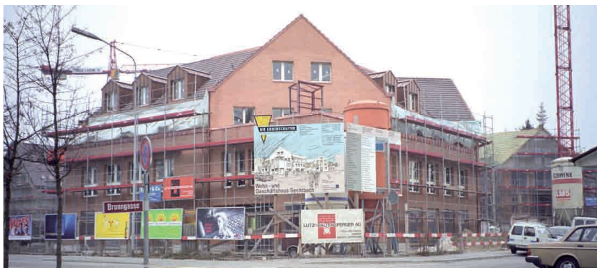
Das Sechtbach-Huus im Bau
