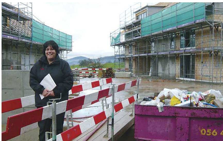
Ursula Kleber nimmt die Baustelle in Augenschein.
